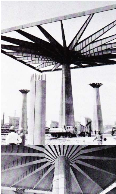
P. L. Nervi, costruzione di un pilastro e risultato finale, 1961
