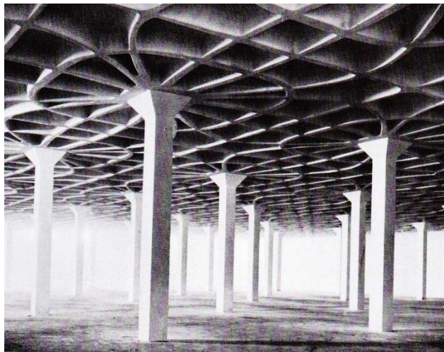
P. L. Nervi, seminterrato lanificio Gatti, 1951
