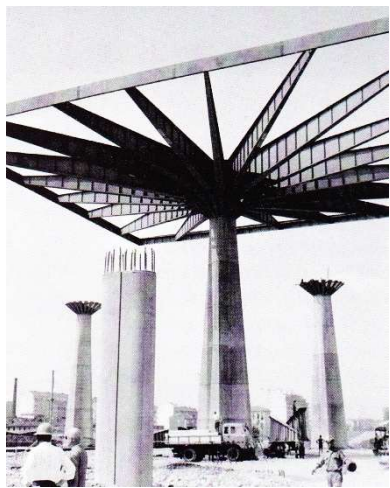
P. L. Nervi, costruzione di un pilastro e risultato finale, 1961
